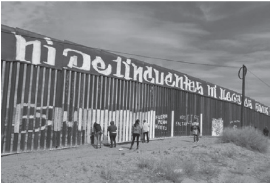
Figura 25. Muro fronterizo entre Ciudad Juárez-El Paso intervenido
